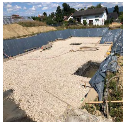
Après travaux d'excavation
