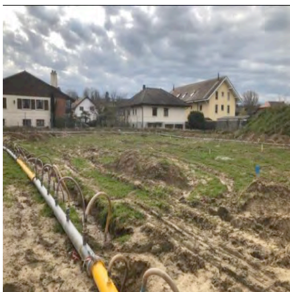
Avant travaux d'excavation
