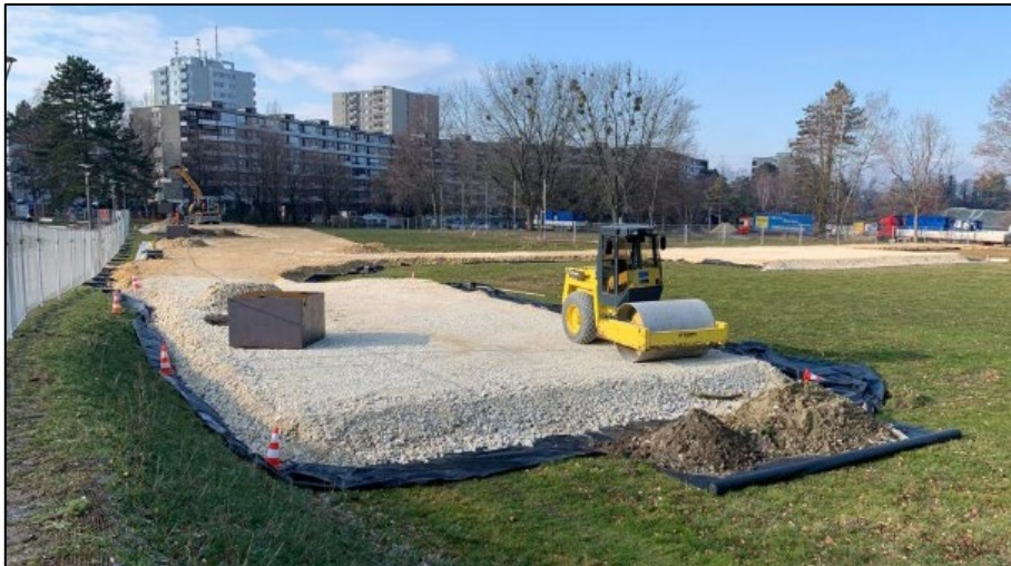
Préparation d'une plateforme
