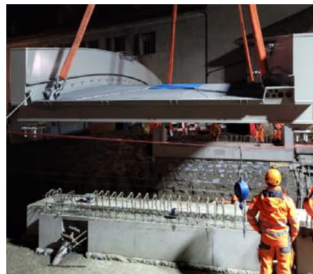
Mise en place du tablier sur les culées préfabriquées lors de l'OCP
