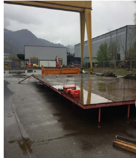
Exemple de zone de préfabrication extérieure avec tables de coffrage et palans
