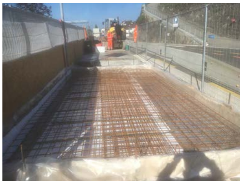
Socle de l'autogruue à bétonner
