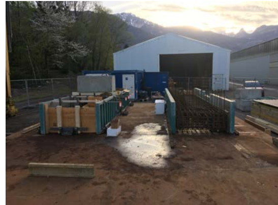
Zone de préfabrication avec coffrage des culées
