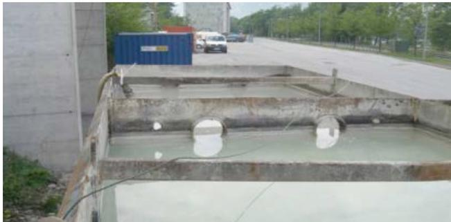
Les eaux d'hydrodémolition sont récoltées dans une station de traitement des eaux. En effet, après avoir rincé le support, l'eau et les résidus subissent plusieurs étapes de décantation pour qu'on puisse enfin rejeter une eau propre à l'exutoire.
