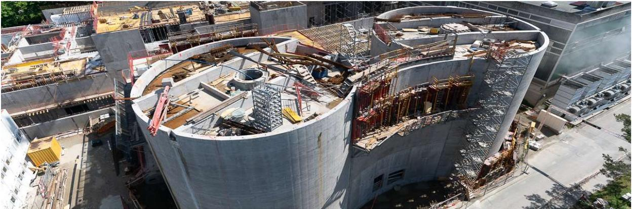
Fig. 8: STEP de Lausanne après bétonnage des silos
