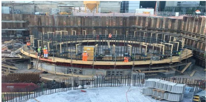
Fig. 5: Montage du coffrage glissant
