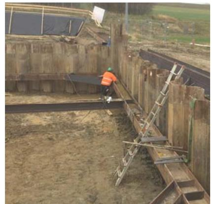
5 et 6 / Terrassement du niveau n°2 en respectant la profondeur convenue. Mise en place de l'ossature n°2 afin de sécuriser la dernière étape d'excavation.
