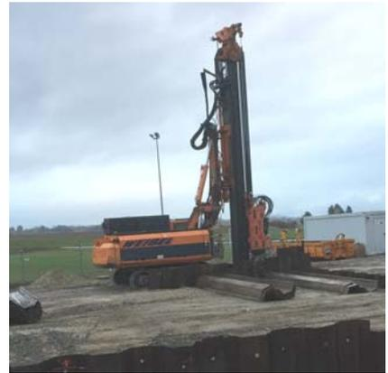
Une fois l'enceinte en place, nous exécutons nos étapes entre excavation et mise en place de blindage de fouille en profilés métalliques à l'avancement. Il est primordial d'établir une approche logique et optimale en collaboration avec l'ingénieur civil afin de coordonner efficacement les travaux de terrassement, de bétonnage et de remblayage tout en assurant la stabilité des parois.
