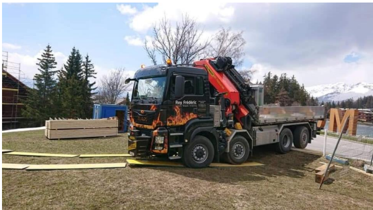
Exemple d'accès sur une place d'installation avec végétation à protéger
