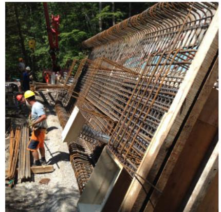
Durant ces travaux spéciaux sur la pile 4, l'entreprise a effectué les cinq étapes de bétonnage contre la fondation de la pile 3. Une place provisoire avait été aménagée afin de pouvoir manœuvrer avec la grue télescopique sur chenilles. La méthode d'exécution de ce renforcement en béton contre cette fondation a été la même que pour la pile 4. Une planification des étapes de bétonnage avait été faite pour qu'il n'y ait pas de temps d'attente entre l'exécution des forages des piles 3 et 4.
