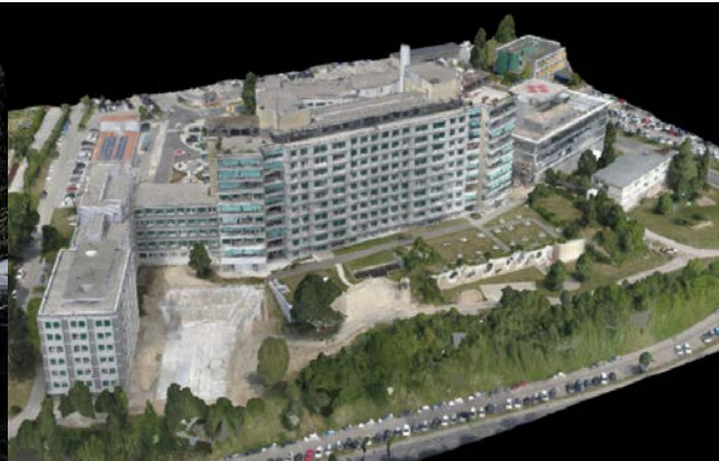
Relevé par photogrammétrie drone de l'hôpital de Fribourg. On notera la fouille en pleine masse en bas à gauche.
