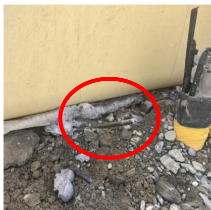
Lance insérée dans le sol
