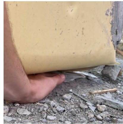
Espace sous l'escalier
