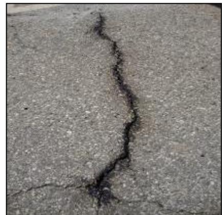
2) Après avoir fait fondre au préalable le mastic d'étanchéité dans le combi-réchaud à bitume (veillez à ne pas dépasser les 180° C), nous remplissons la fissure encore chaude de mastic à l'aide de l'entonnoir de bitume chauffable. Afin de garantir la durabilité du traitement, il est important de remplir la fissure 1 mm plus bas que le niveau de la route.
