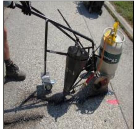
3) Lorsque le produit est encore bien chaud, nous épandons une couche de gravillons à la surface du joint. Seuls les gravillons en contact avec le bitume colleront, c'est pourquoi il n'est pas utile d'en mettre plus que l'épaisseur du grain. Lors de longues fissures, il est possible d'épandre les gravillons à l'aide d'une gravillonneuse. Les gravillons doivent être maintenus au sec sinon ils risquent de se décoller rapidement du mastic.
