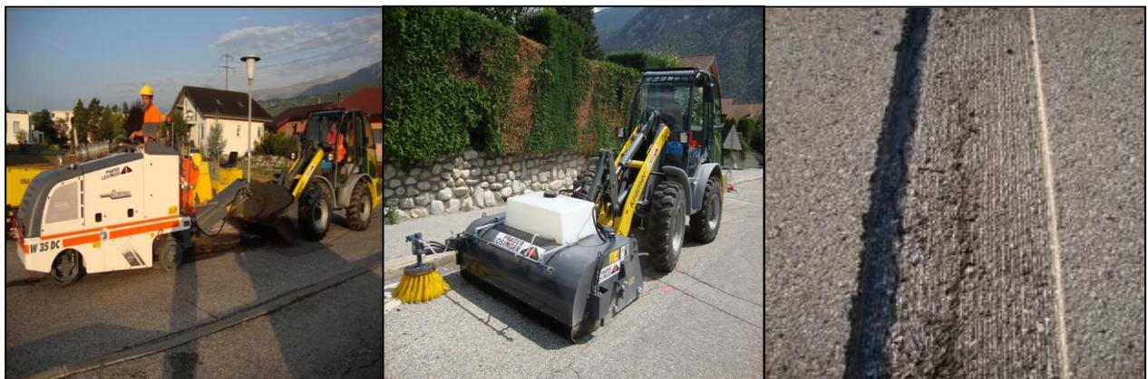
2) Si la fissure est encore présente au fond de la partie fraisée, il faut la traiter afin de garantir son étanchéité aux eaux d'infiltration. Cette étape s'effectue à l'aide du mastic d'étanchéité comme expliqué au chapitre « Traitement de fissures à l'aide de mastic d'étanchéité ». Ensuite, nous appliquons l'émulsion bitumineuse sur toute la partie fraisée, y compris sur les faces latérales.
