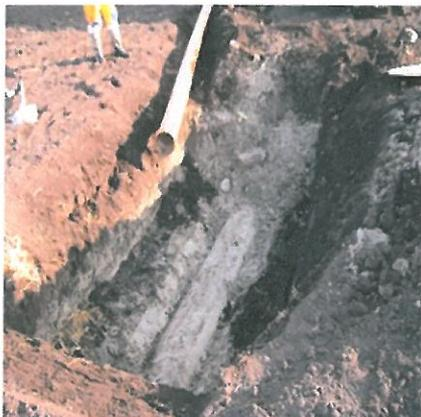
pose du tuyau pour l'évacuation de l'eau qui sera montée par gravitation
