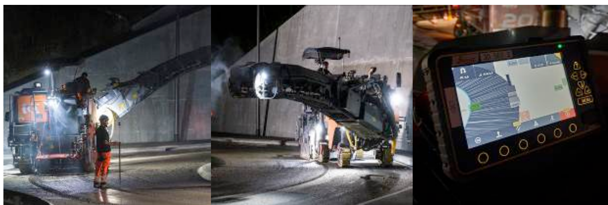
Photo : Contrôle de l'enrobé fraisé/fraisage en arrondi et en devers/Vue du système 3D EPALINGES/RC601 (Marc-André Marmillod – DGMR - REPROAD)
