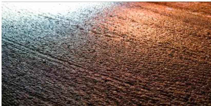
Photo : Résultat après balayage EPALINGES/RC601 (Marc-André Marmillod - DGMR)
