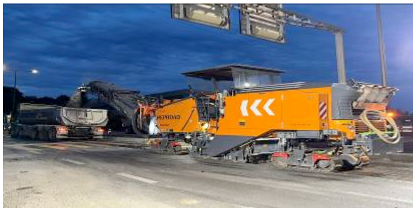
Fraisage d'un carrefour - EPALINGES/RC601 (Photo :Thibaud Michel)
