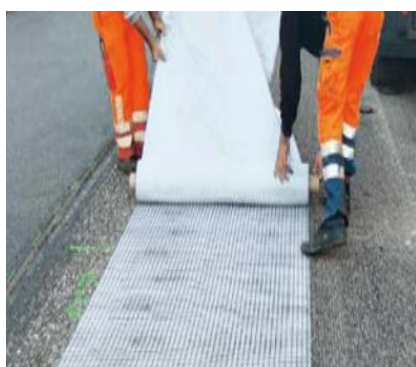
Pose du système SYTEC Gridseal® Patch
