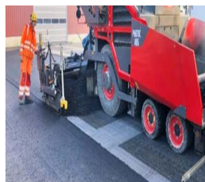
Application du revêtement
