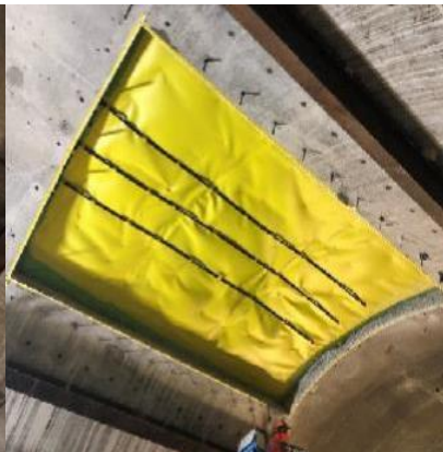
Vue de l'ouverture terminée
