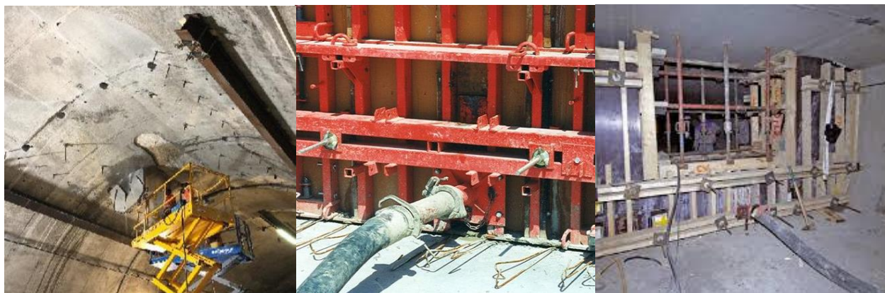
Rénovation d'une voûte
