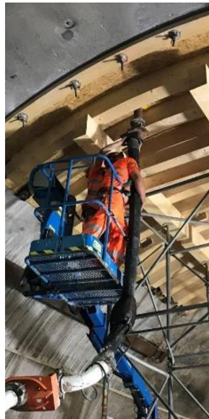
Bétonnage chantier tunnel « Les Vignes »
