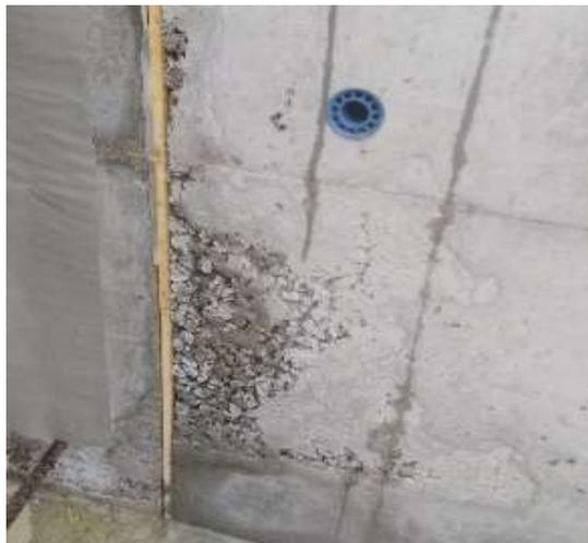
Ci-dessus, un exemple de perte de laitance lors d'une reprise de bétonnage
