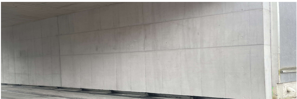
Murs 1 face contre ouvrage existant en béton recyclé
